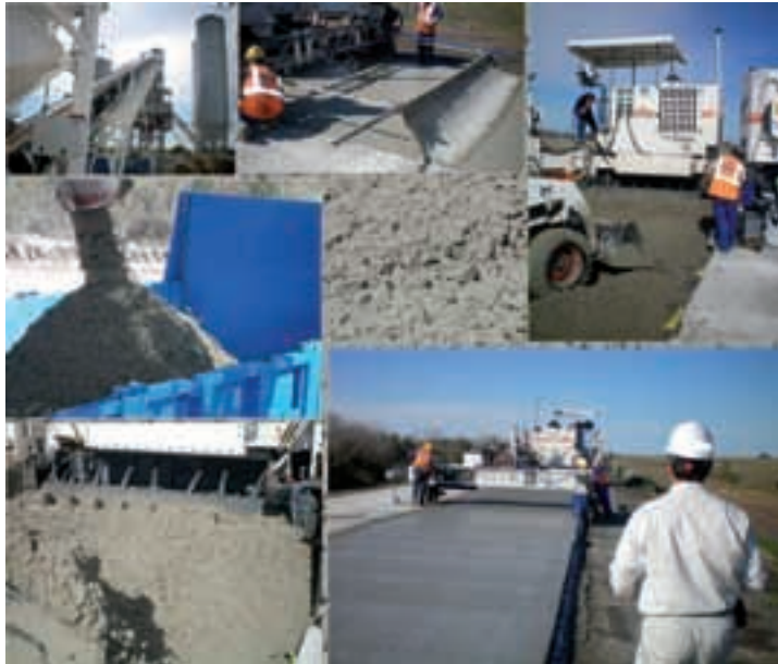
► F.3. Empleo de macrofibras sintéticas en un whitetopping adherido empleado para la reparación y refuerzo de la Ruta 24 en la República Oriental del Uruguay (7)
